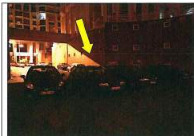
Visível a falta de Segurança passiva (Falta de qualquer iluminação Pública)
